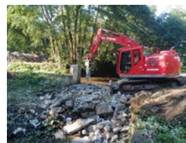
Seuil de Tiquetorte - intervention pour arasement
