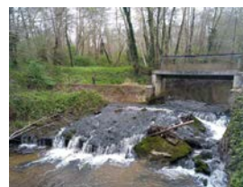
Seuil de Tiquetorte - avant travaux d'arasement
